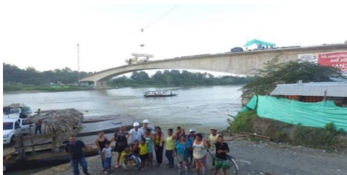
Planchón de Valencia y Puente en Construcción - Foto Heraldo 2017
